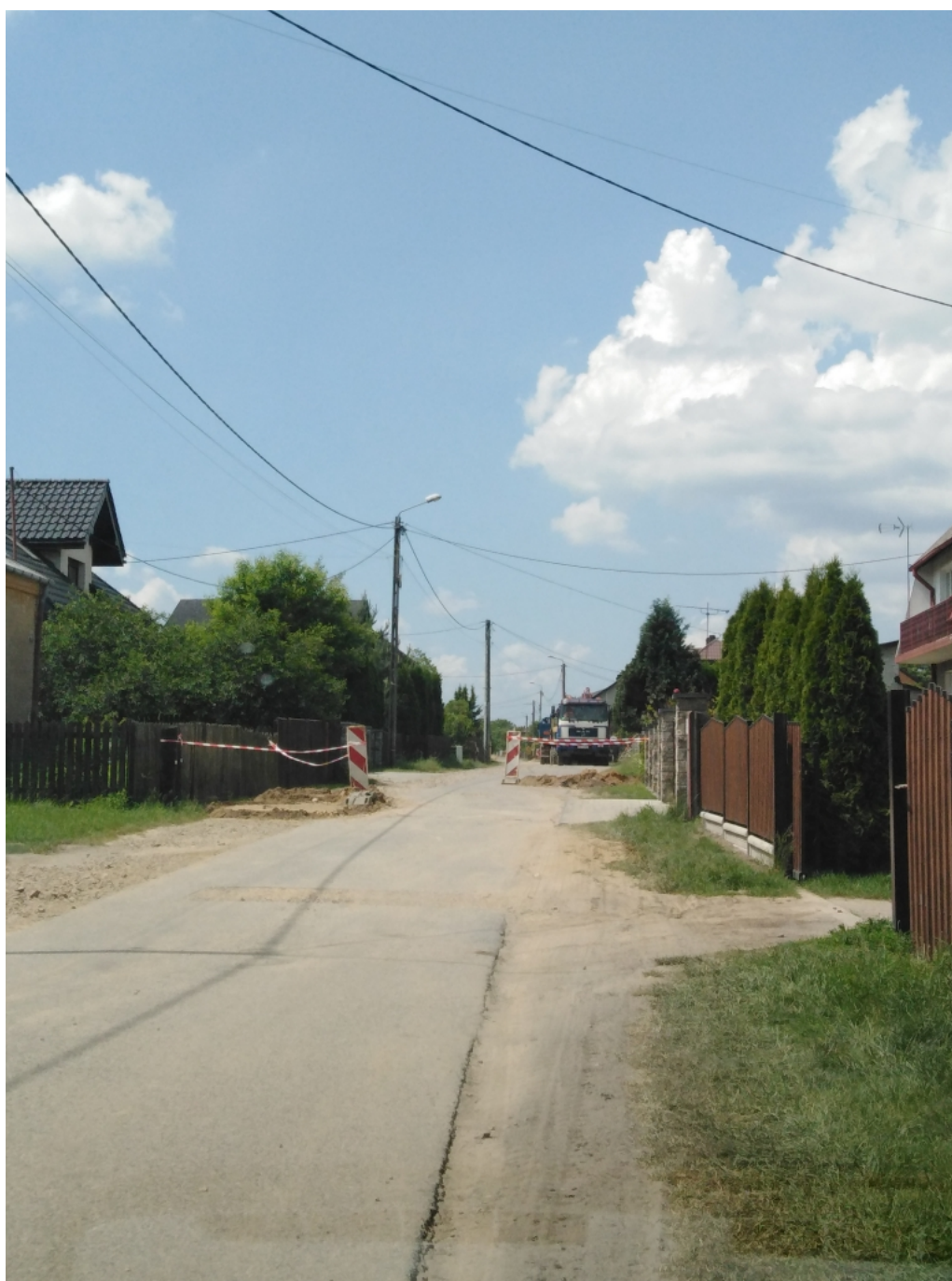
Rysunek 72: Budowa kanalizacji sanitarnej w Izbickach
