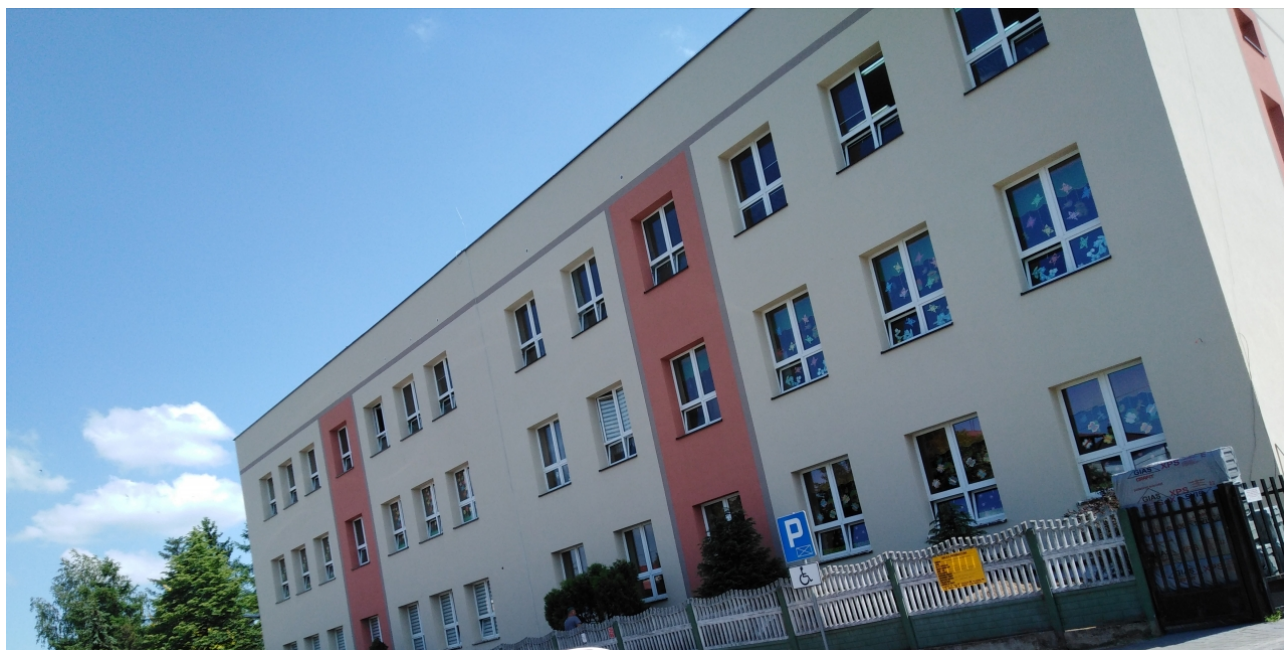
Rysunek 74: Termomodernizacja budynku ZSP Miedźno
