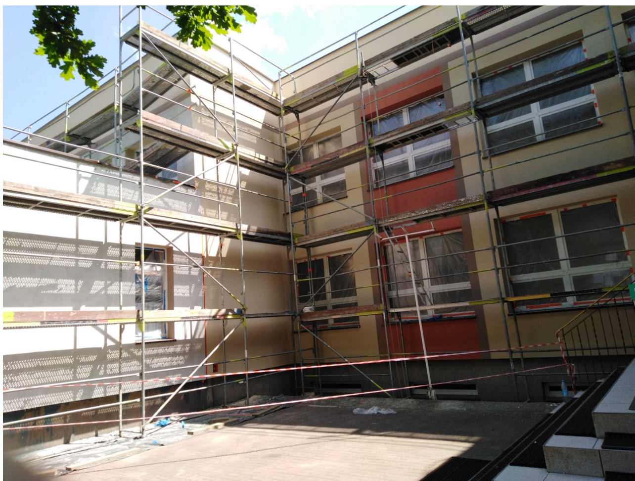
Rysunek 73: Termomodernizacji budynku ZSP Miedźno
