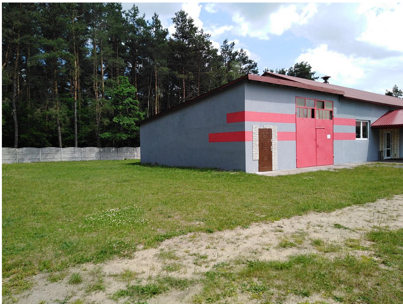
Rysunek 78: Ogrodzenie i remont elewacji Strażnicy OSP Władysławów
