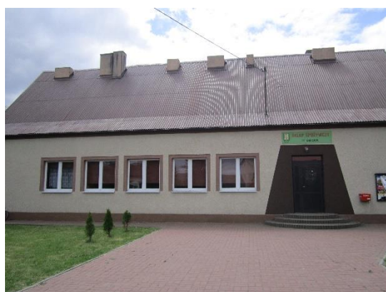
Rysunek 43. Budynek świetlicy wiejskiej w Izbiskach (źródło: CDE Sp. z o.o.)
