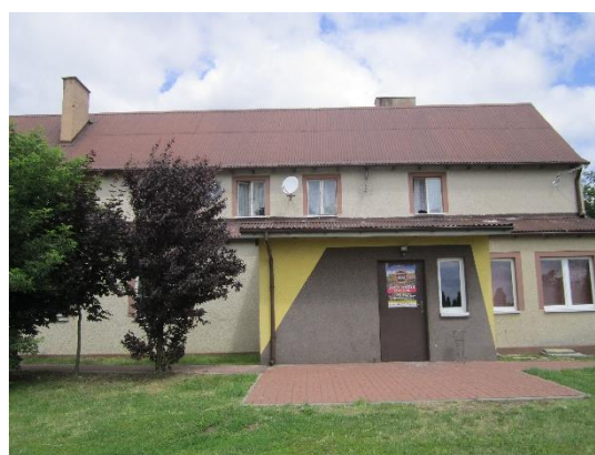
Rysunek 45. Budynek świetlicy wiejskiej w Izbiskach (źródło: CDE Sp. z o.o.)
