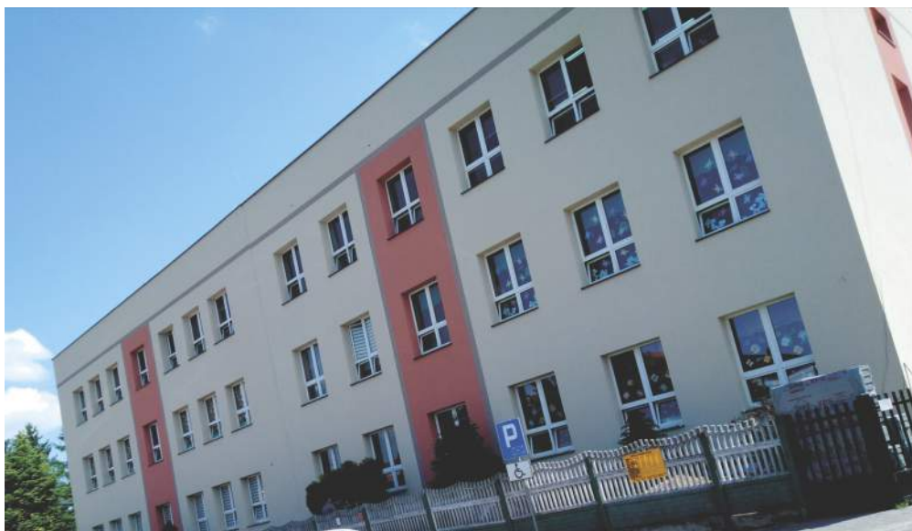
Rysunek 74: Termomodernizacja budynku ZSP Miedźno
