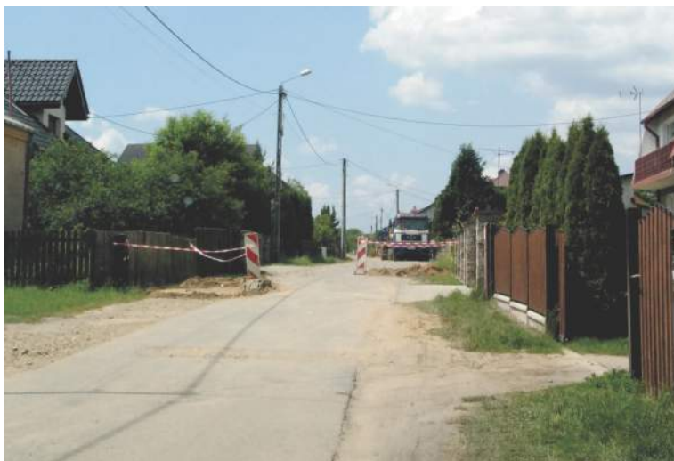
Rysunek 72: Budowa kanalizacji sanitarnej w Izbiskach
