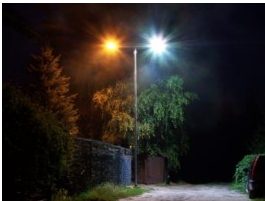
RYSUNEK 5 FOTOGRAFIA PRZEDSTAWIAJĄCA OŚWIETLENIE ŹRÓDŁEM SODOWYM (LEWA STRONA, MOC 75 W) I OŚWIETLENIEM TYPU LED (PRAWA STRONA, MOC 30W), ŹRÓDŁO: HTTP://WWW.KP-LIGHTING.COM/PL/CONTENT/MAIN_PICTURES/SODAVSLED.JPG
