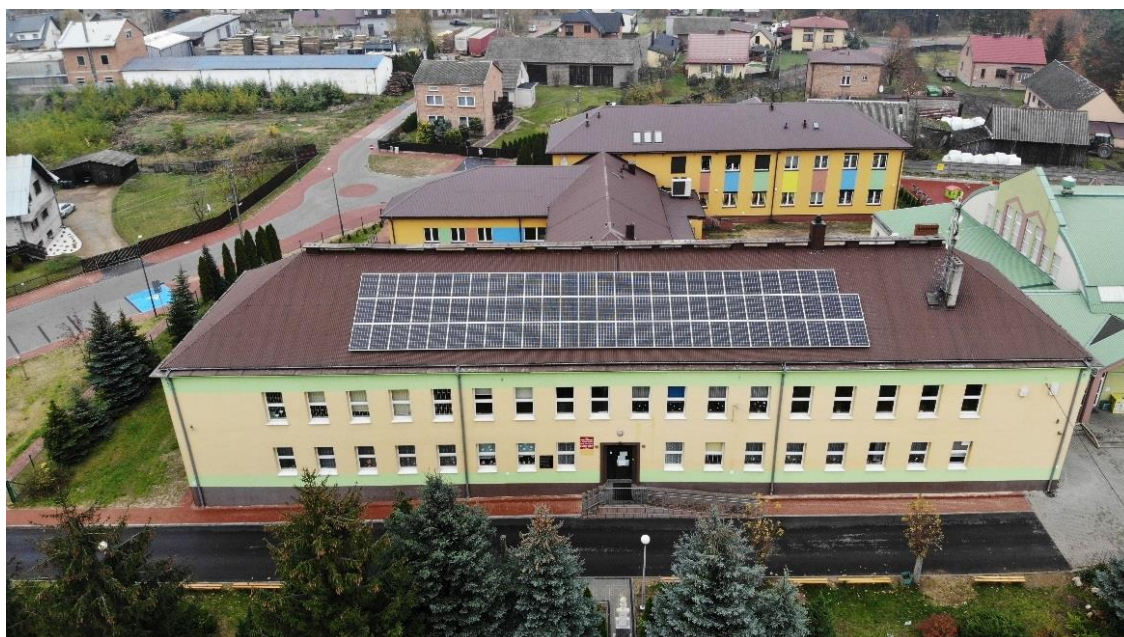
Zdjęcie 4. Instalacja fotowoltaiczna na budynku Zespołu Szkolno – Przedszkolnego w Ostrowach nad Okszą
