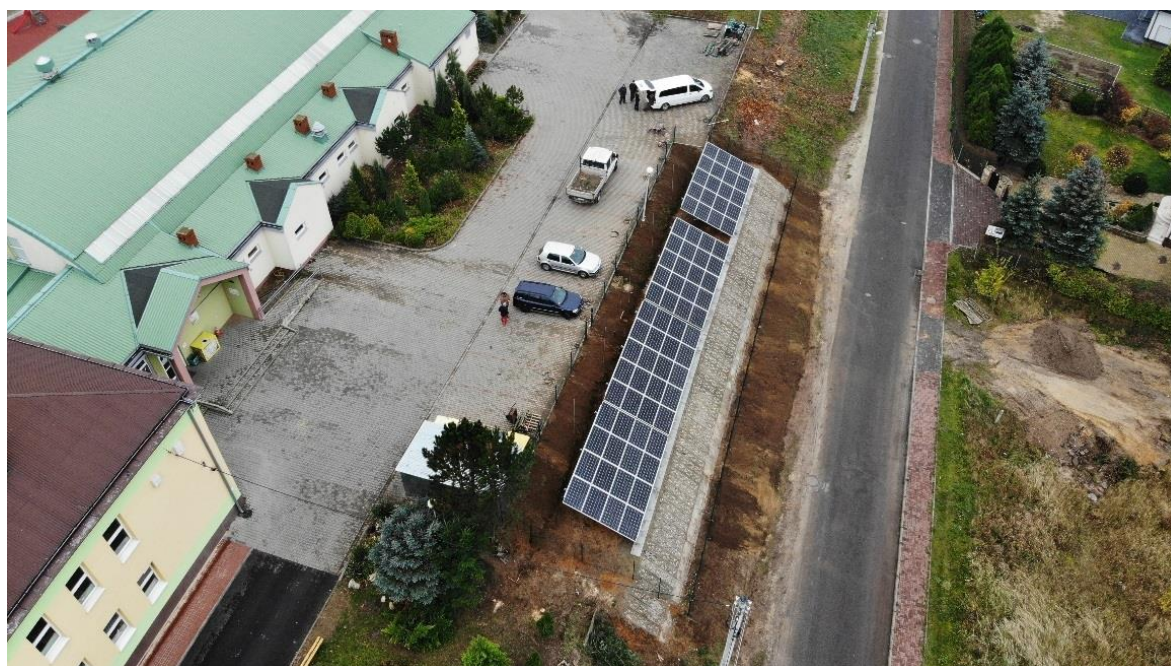
Zdjęcie 5. Instalacja fotowoltaiczna przed halą sportową w Ostrowach nad Okszą
