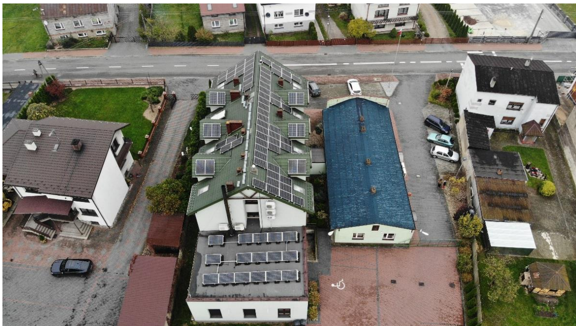
Zdjęcie 6. Instalacja fotowoltaiczna na budynku Urzędu Gminy Miedźno
