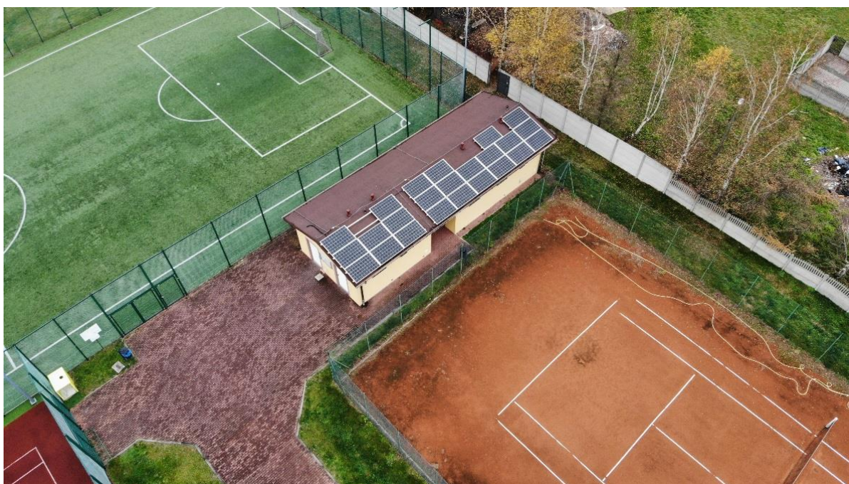
Zdjęcie 7. Instalacja fotowoltaiczna na kompleksie boisk sportowych Orlik
