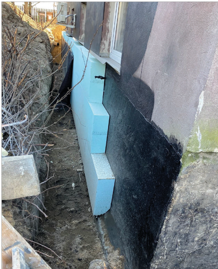
Zdjęcie 17 Termomodernizacja ZSP w Mokrej
