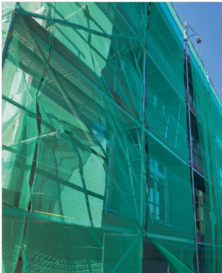
Zdjęcie 16 Termomodernizacja ZSP w Mokrej
