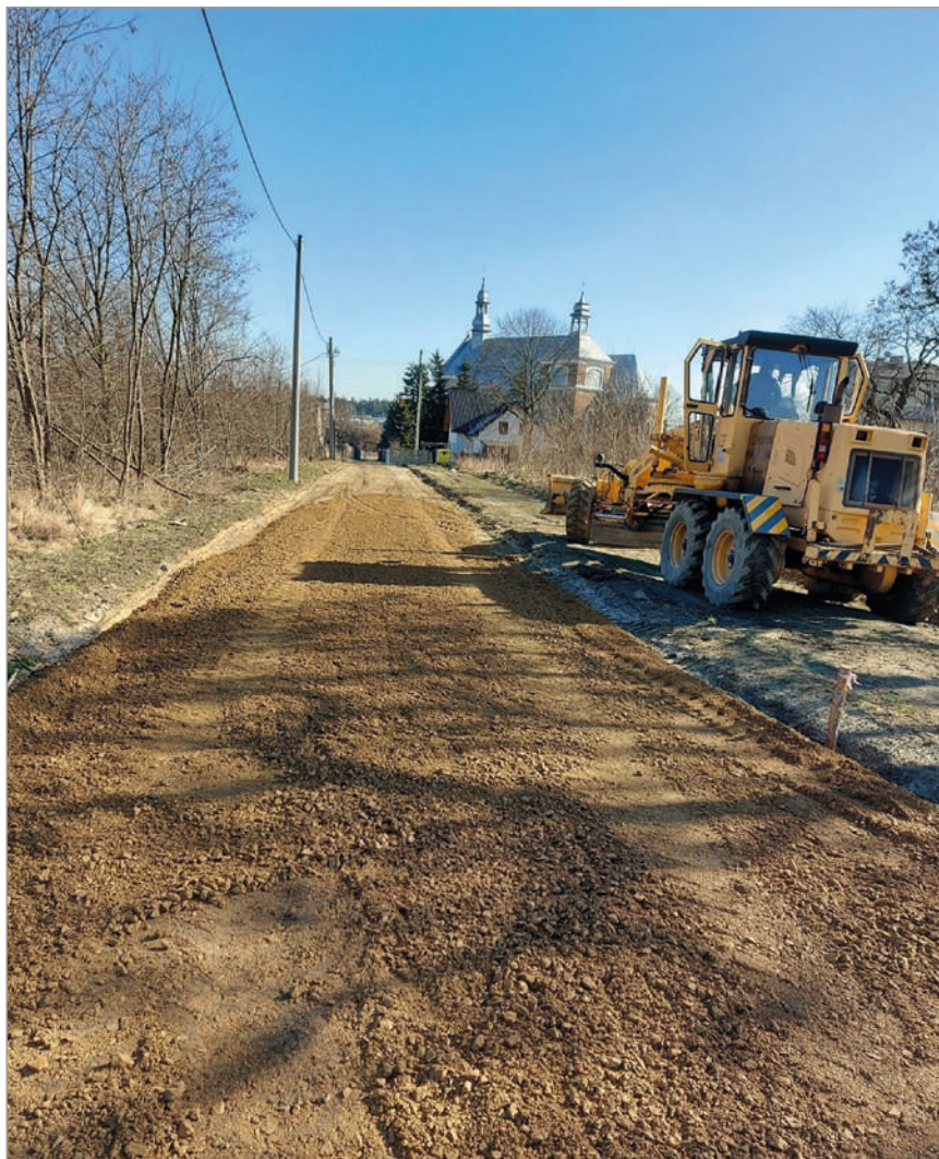
Zdjęcie 11 Przebudowa ul. Wąskiej w Ostrowach nad Okszą
