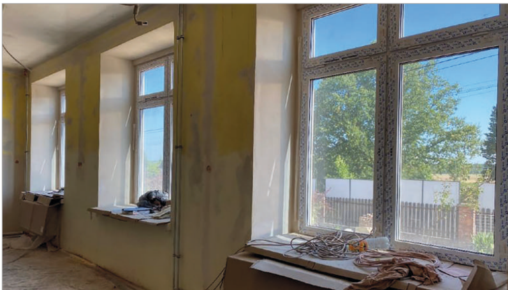
Zdjęcie 15 Termomodernizacja ZSP w Mokrej
