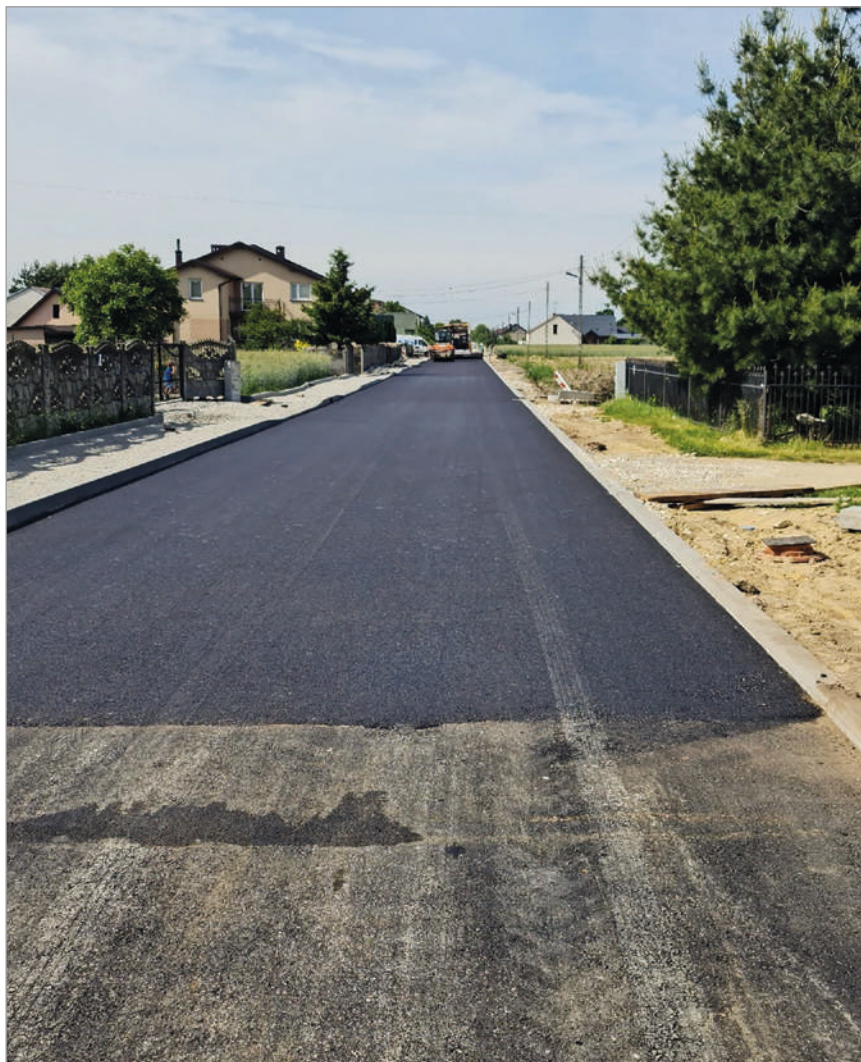
Zdjęcie 9 Przebudowa ulicy Dębowej w Miedźnie (warstwa wiążąca)
