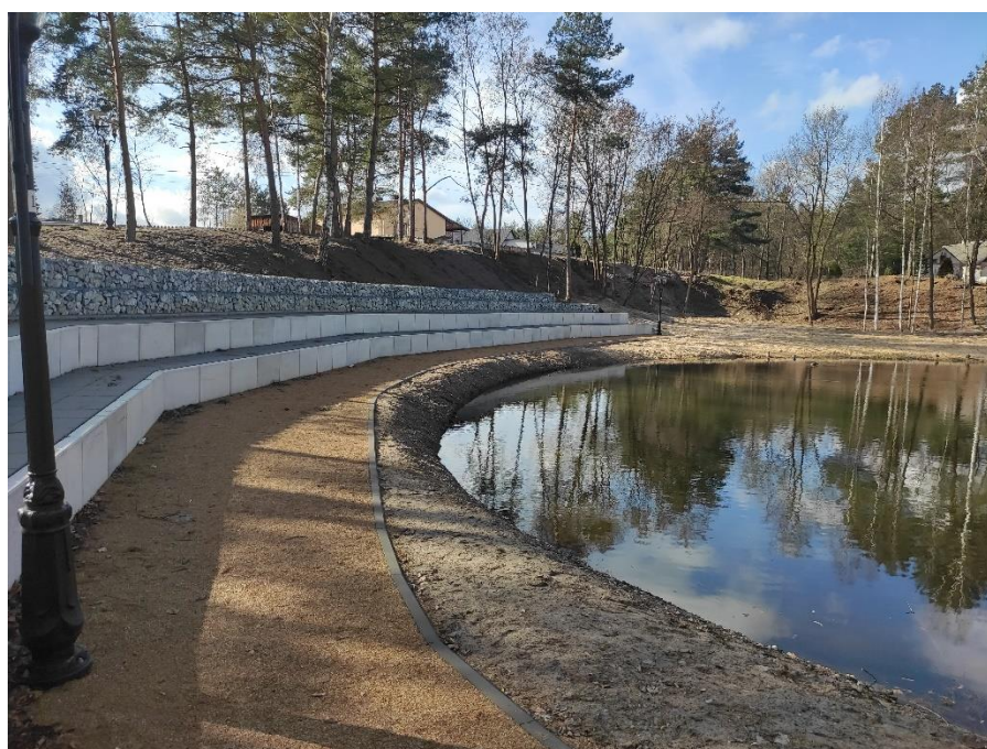
Zdjęcie 27 Przebudowa ul. Sosnowej w Miedźnie
