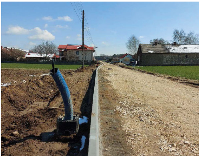
Zdjęcie 27 Przebudowa ul. Sosnowej w Miedźnie
