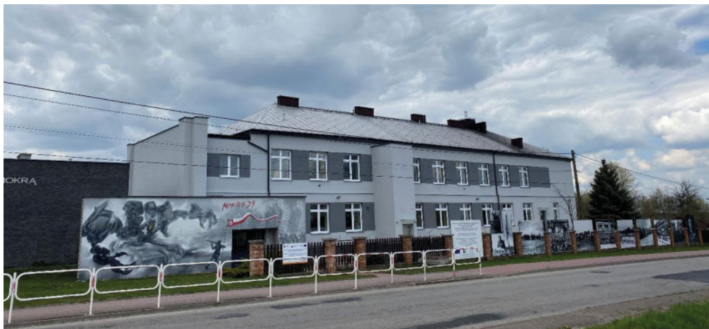
Zdjęcie 12 Przebudowa i termomodernizacja budynku ZSP w Mokrej
