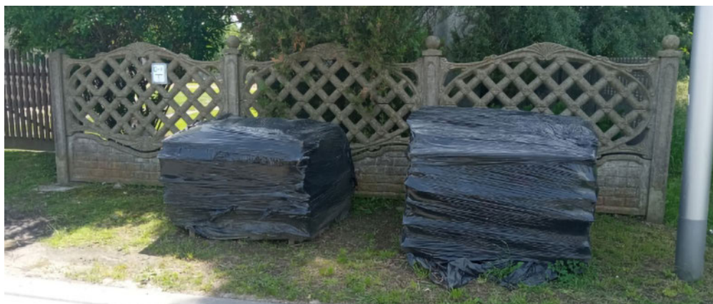
Zdjęcie 80 Zabezpieczony i przygotowany do odbioru azbest
