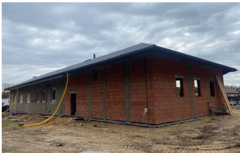
Zdjęcie 21 Przebudowa i termomodernizacja Strażnicy OSP Władysławów
