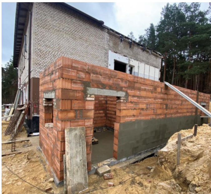
Zdjęcie 24 Przebudowa i termomodernizacja Strażnicy OSP Borowa
