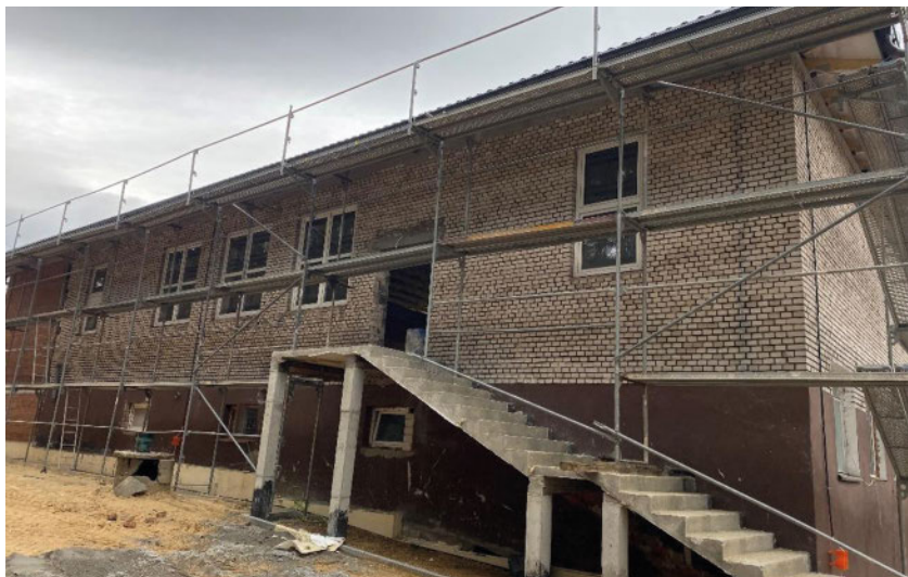
Zdjęcie 23 Przebudowa i termomodernizacja Strażnicy OSP Borowa
