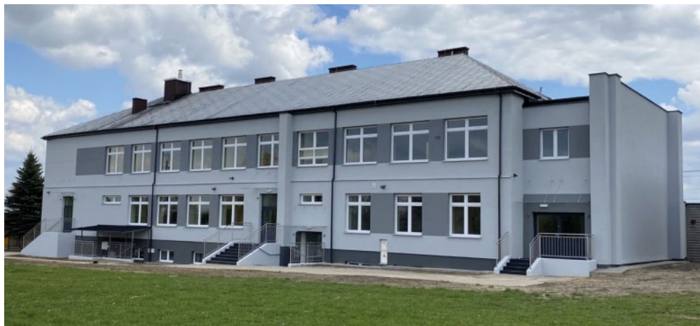
Zdjęcie 10 Przebudowa i termomodernizacja budynku ZSP w Mokrej
