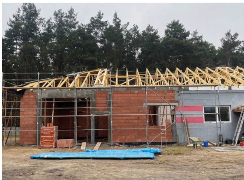
Zdjęcie 22 Przebudowa i Termomodernizacja Strażnicy OSP Władysławów
