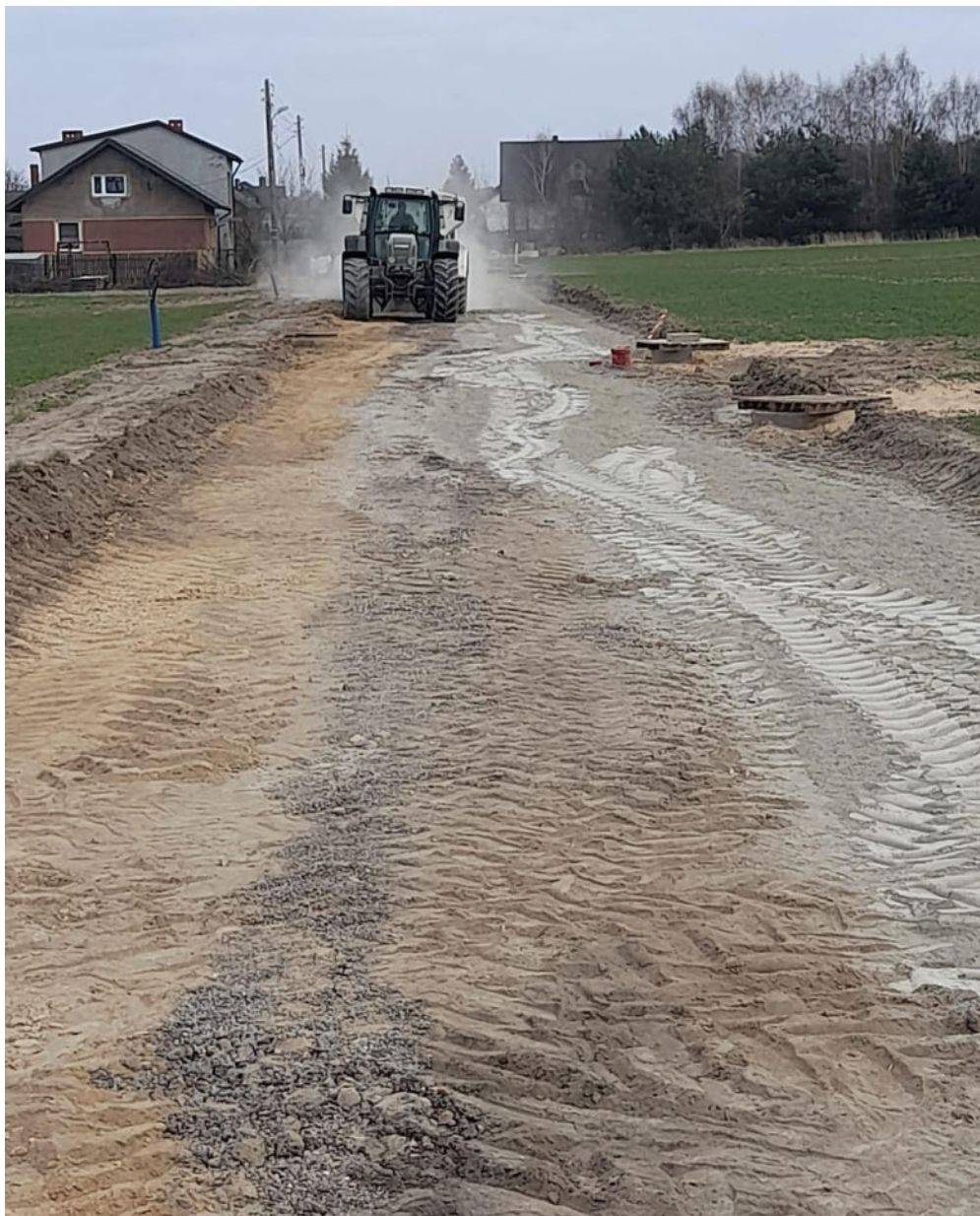
Zdjęcie 20 Przebudowa ul. Sosnowej w Miedźnie
