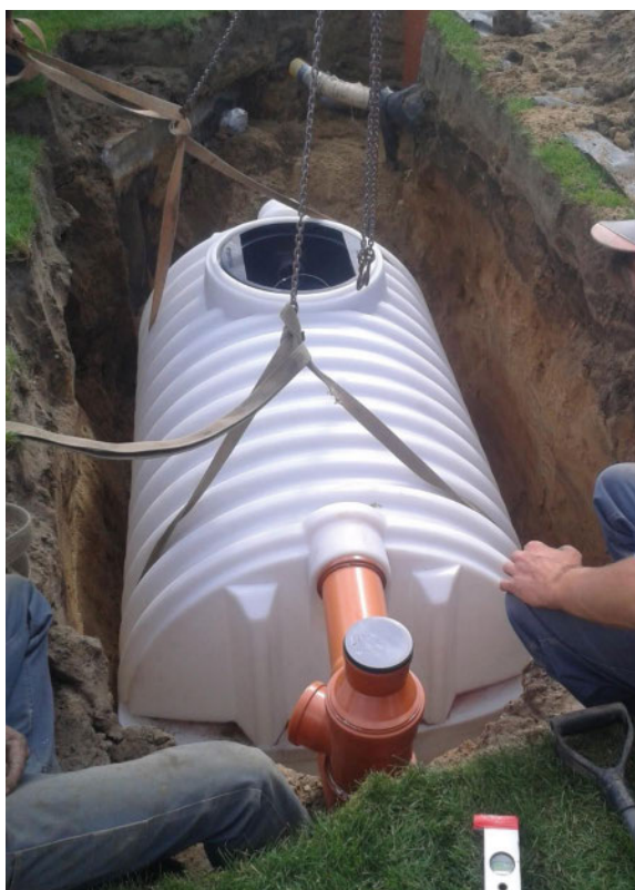
Zdjęcie 78 Montaż przydomowej oczyszczalni ścieków
