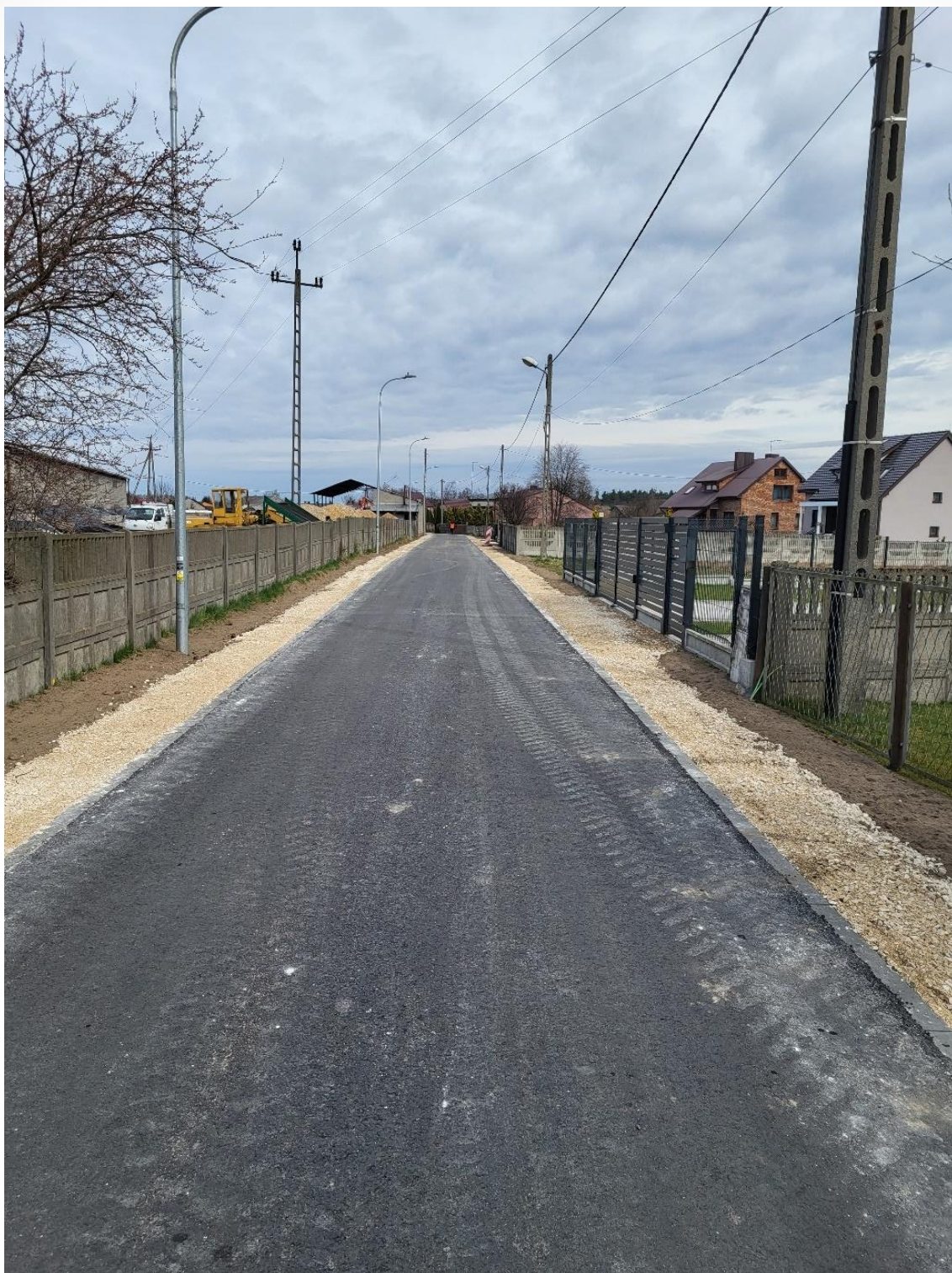
ZDJĘCIE 8 PRZEBUDOWA UL. OGRODOWEJ W OSTROWACH NAD OKSZĄ
