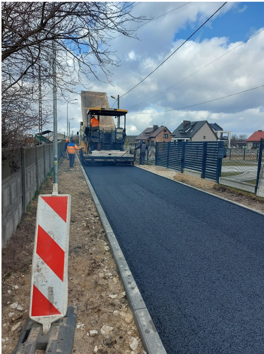
ZDJĘCIE 9 PRZEBUDOWA UL. OGRODOWEJ W OSTROWACH NAD OKSĄ
