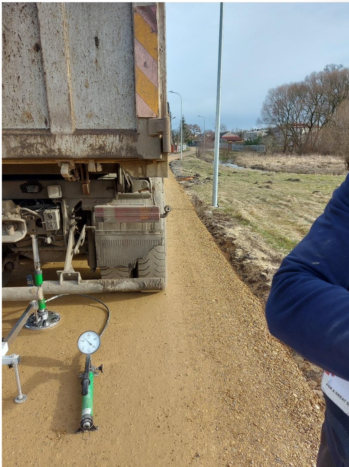
ZDJĘCIE 7 BADANIE ZAGĘSZCZENIA PODBUDOWY UL. ŁAKOWA OSTROWY NAD OKSZĄ
