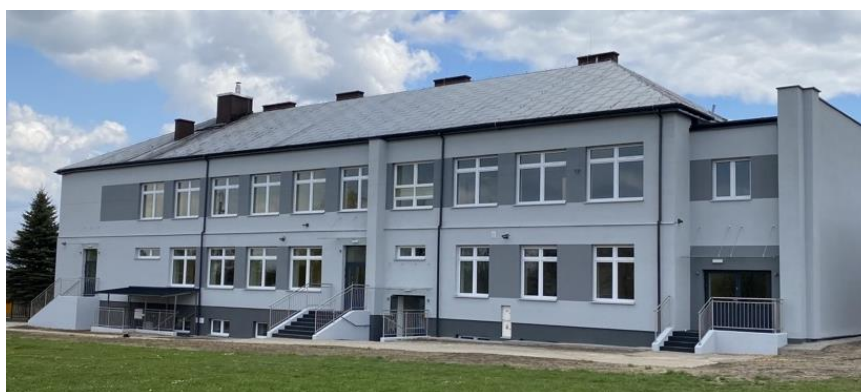
ZDJĘCIE 29 BUDYNEK ZSP W MOKREJ PO PRZEBUDOWIE I TERMOMODERNIZACJI
