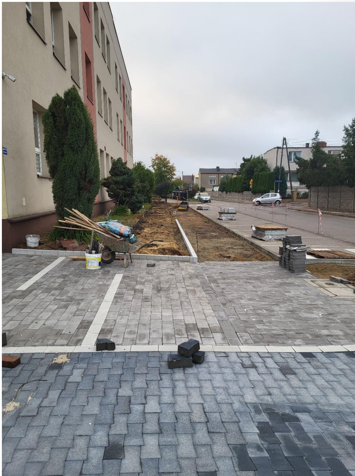
ZDJĘCIE 12 UTWARDZENIE PLACU PRZY ZSP MIEDŹNO
