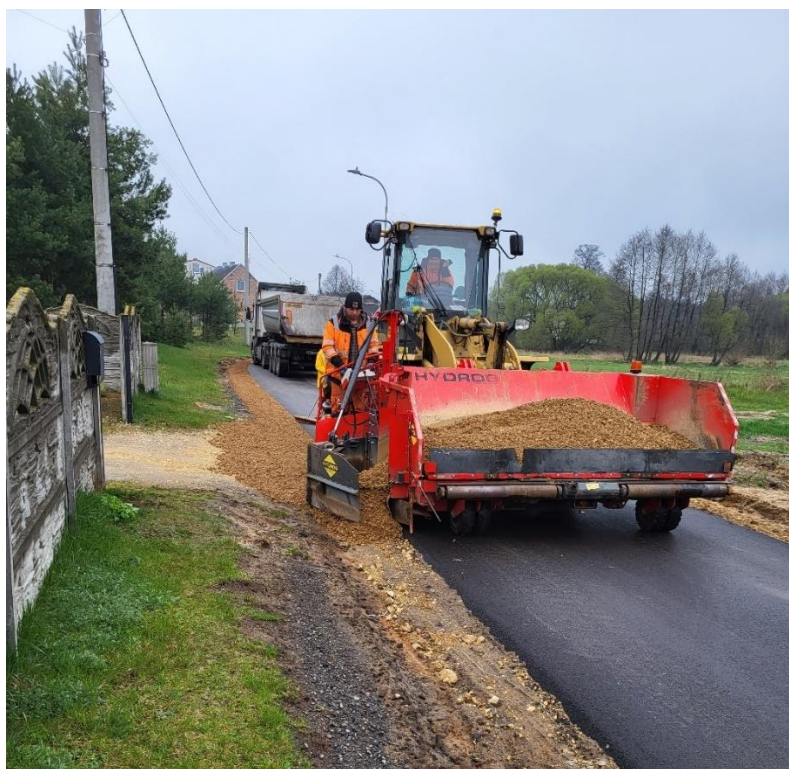
ZDJĘCIE 3 BUDOWA POBOCZA UL. ŁĄKOWA OSTROWY NAD OKSZĄ
