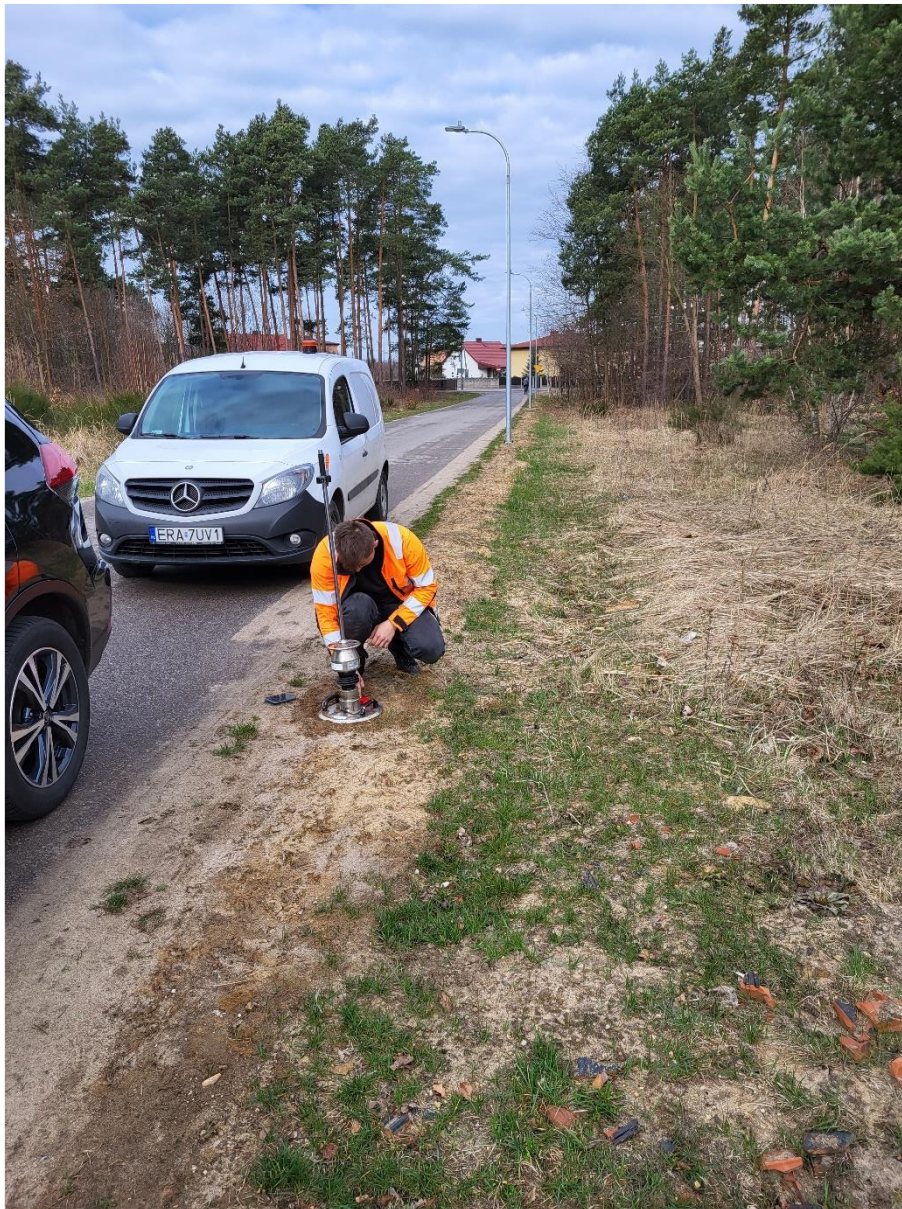
ZDJĘCIE 31 BADANIE ZAGĘSZCZENIA GRUNTU PO WYKONANIU OŚWIEPLENIA ULICZNEGO – OSTROWY NAD OKSZĄ
