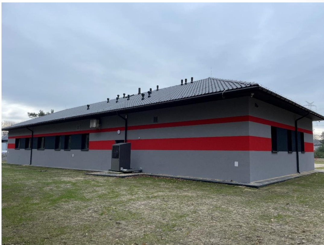
ZDJĘCIE 25 BUDYNEK REMIZY OSP WE WŁADYSŁAWOWIE PO PRZEBUDOWIE I TERMOMODERNIZACJI
