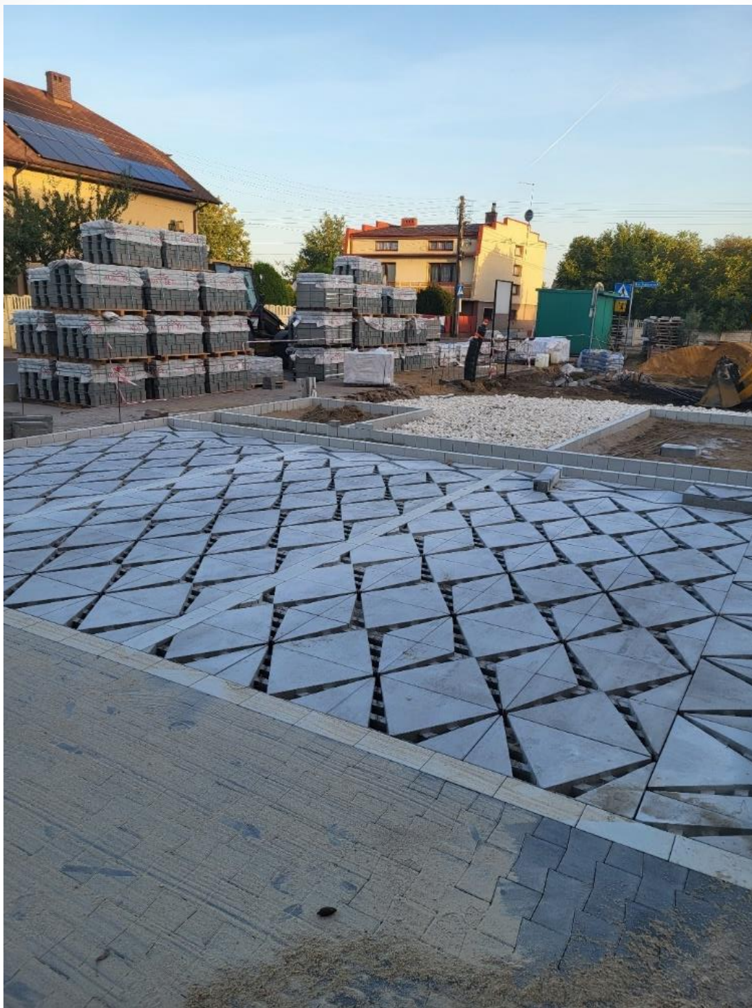
ZDJĘCIE 11 UTWARDZENIE PLACU PRZY ZSP MIEDŹNO
