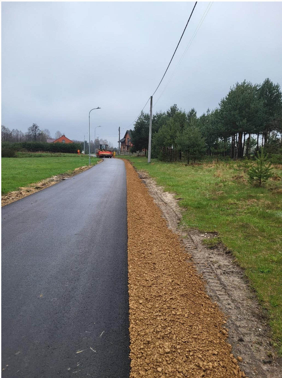
ZDJĘCIE 6 BUDOWA POBOCZA UL. ŁĄKOWA OSTROWY NAD OKSZĄ
