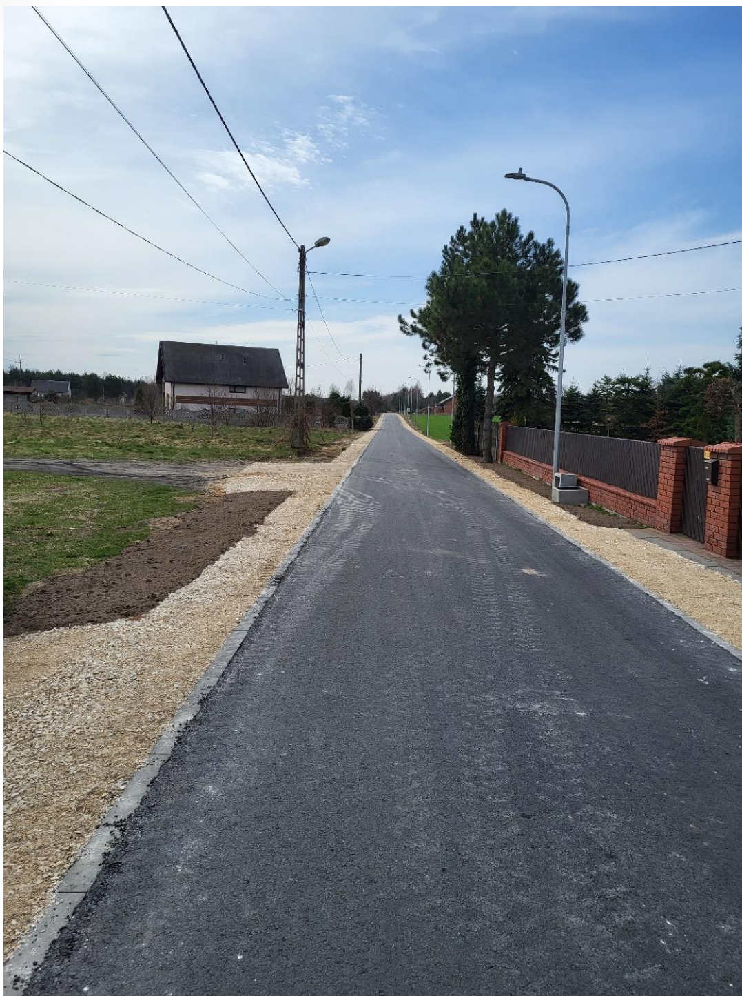
ZDJĘCIE 10 PRZEBUDOWA UL. OGRODOWEJ W OSTROWACH NAD OKSĄ
