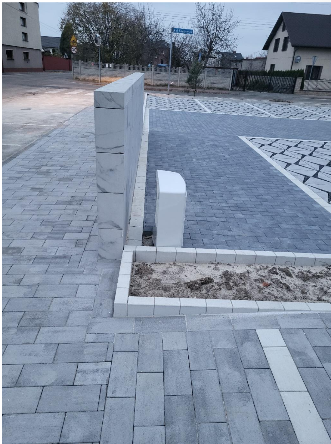
ZDJĘCIE 16 UTWARDZENIE PLACU PRZY ZSP MIEDŹNO
