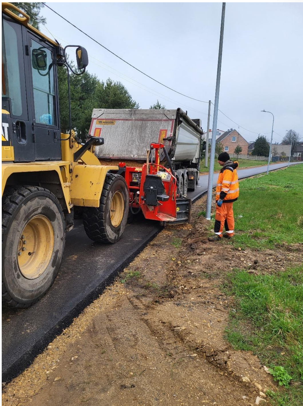
ZDJĘCIE 5 BUDOWA POBOCZA UL. ŁAKOWA OSTROWY NAD OKSZA
