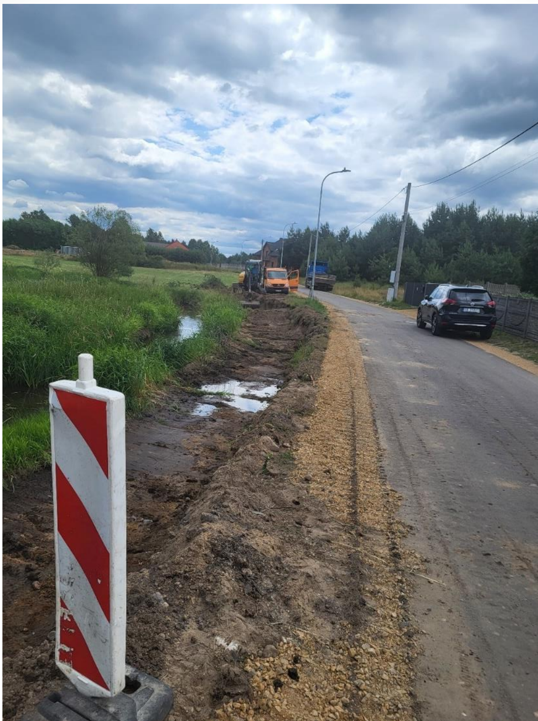
ZDJĘCIE 4 BUDOWA POBOCZA UL. ŁĄKOWA OSTROWY NAD OKSZĄ
