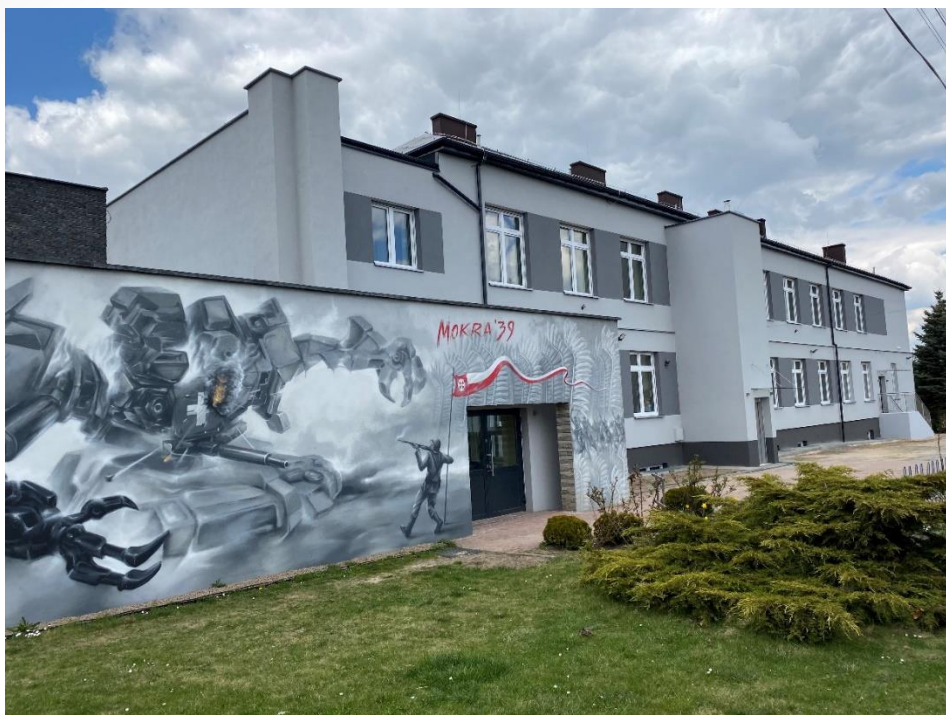
ZDJĘCIE 28 BUDYNEK ZSP W MOKREJ PO PRZEBUDOWIE I TERMOMODERNIZACJI
