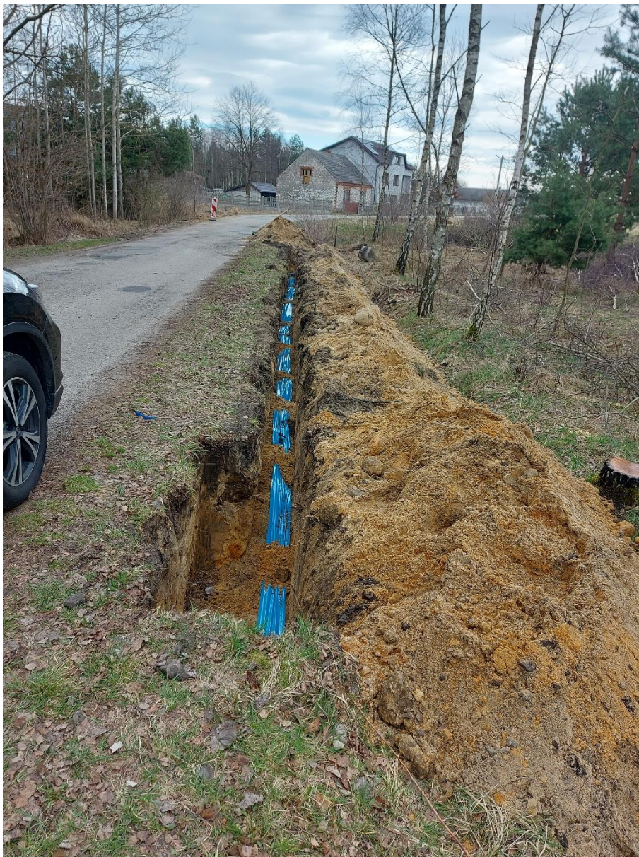
ZDJĘCIE 30 BUDOWA OŚWIETLENIA ULICZNEGO – RYWACZKI
