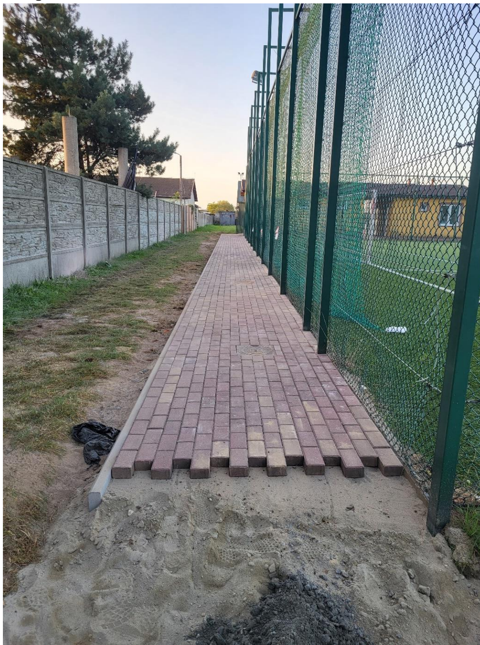
ZDJĘCIE 17 BUDOWA CHODNIKA PRZY ZSP ORAZ KOMPLEKSIE ORLIK W MIEDŹNIE
