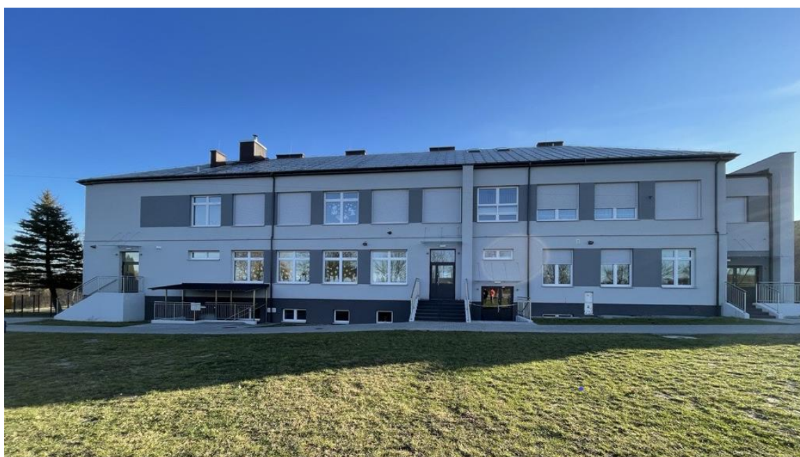
ZDJĘCIE 27 BUDYNEK ZSP W MOKREJ PO PRZEBUDOWIE I TERMOMODERNIZACJI
