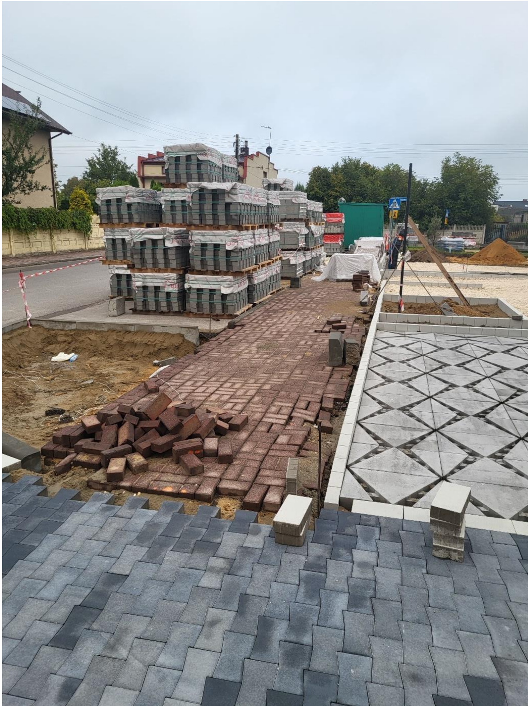
ZDJĘCIE 14 UTWARDZENIE PLACU PRZY ZSP MIEDŹNO
