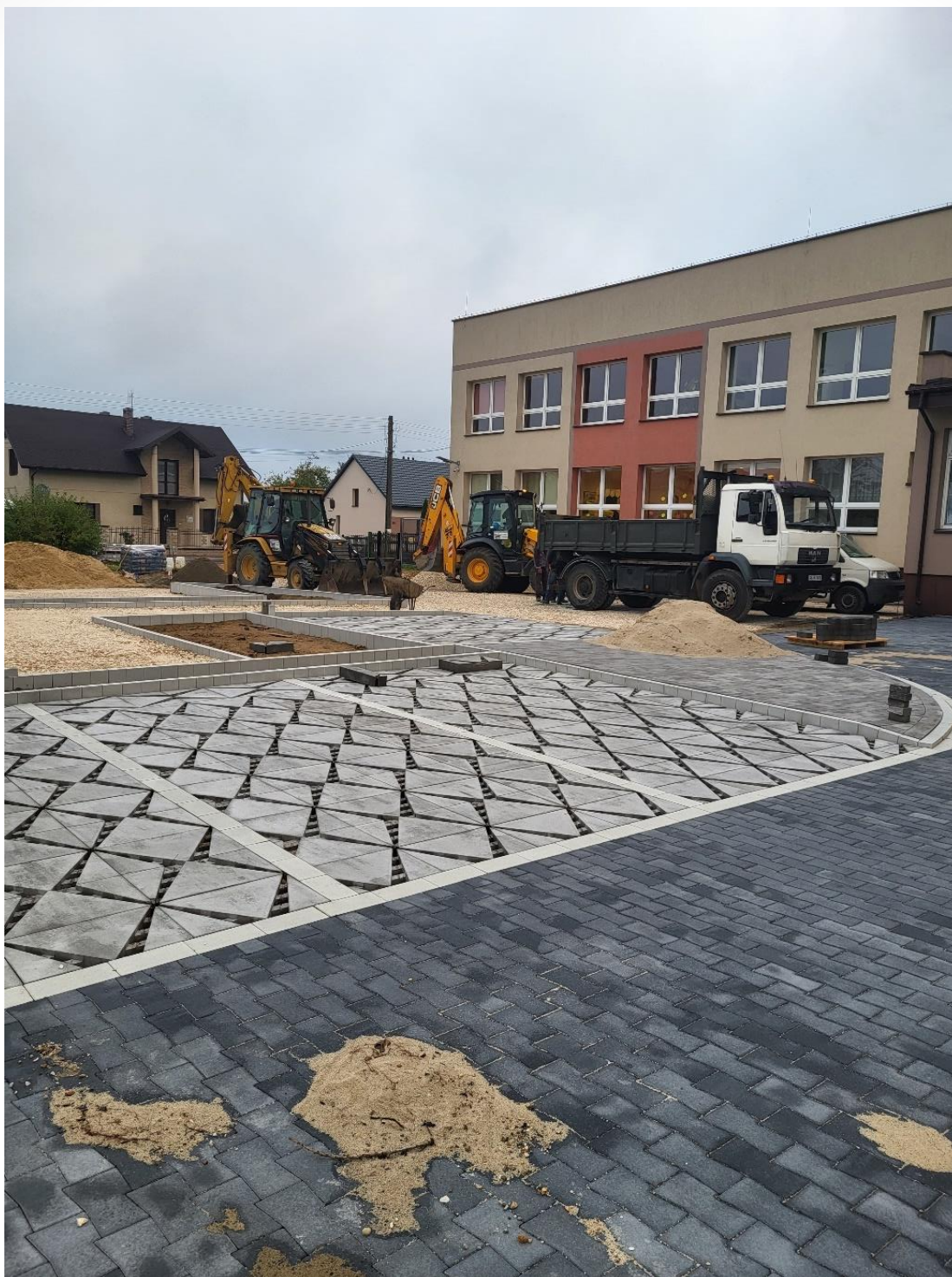
ZDJĘCIE 13 UTWARDZENIE PLACU PRZY ZSP MIEDŹNO
