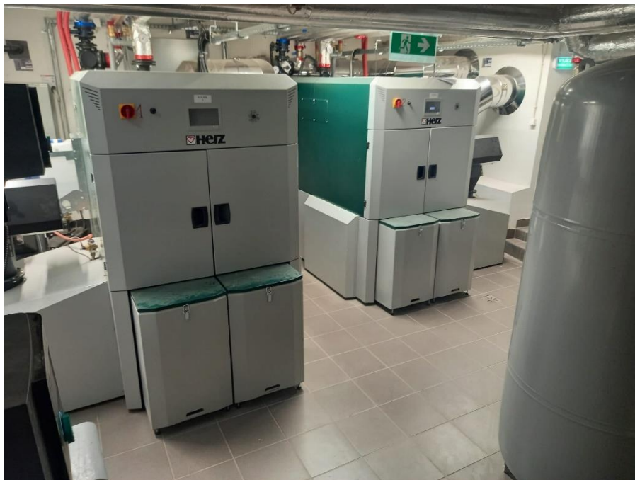
ZDJĘCIE 20 ZMODERNIZOWANA KOTŁOWNIA W ZSP W OSTROWACH NAD OKSZĄ
