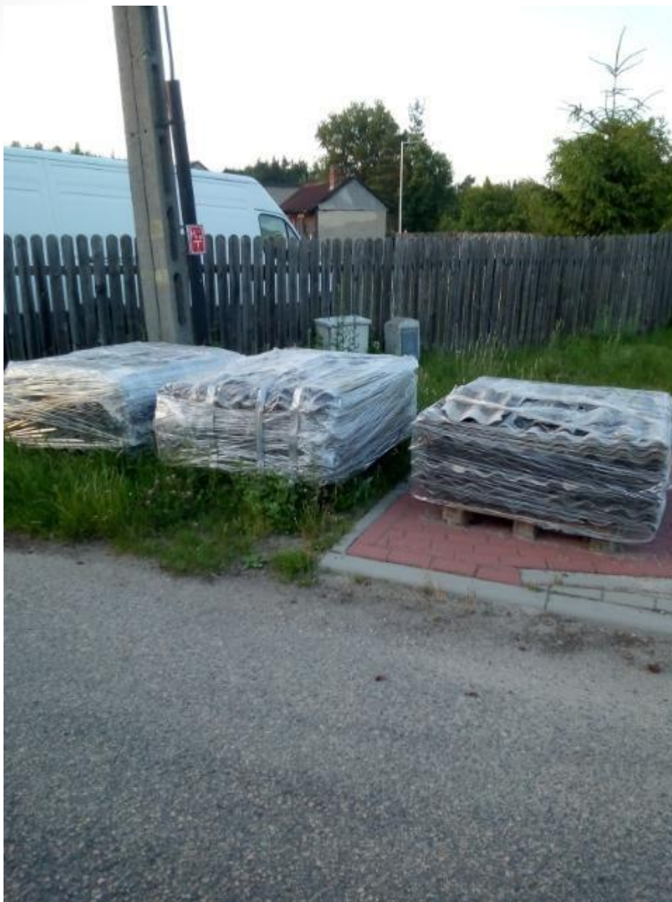
ZDJĘCIE 84 ZABEZPIECZONY I PRZYGOTOWANY DO ODBIORU AZBEST.
