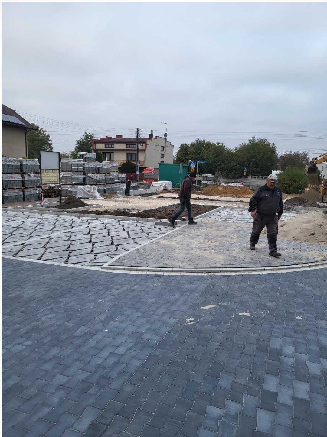
ZDJĘCIE 15 UTWARDZENIE PLACU PRZY ZSP MIEDŹNO
